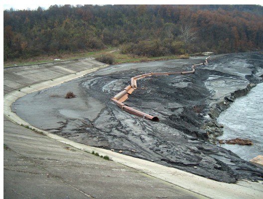
Fig.5–Zona amonte baraj și vedere dig mal drept (cu lacul gol)
