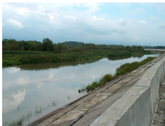
Fig.7–Vedere coada lacului și dig mal stâng
