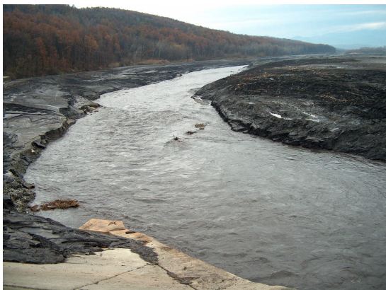
Fig.4–Zona pod și vedere dig mal drept (cu lacul gol)
