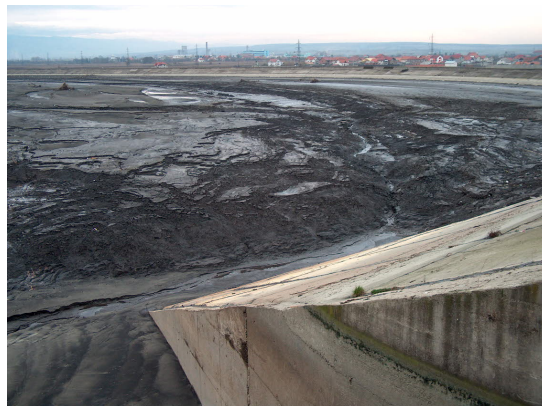
Fig.3–Zona pod și vedere dig mal stâng (cu lacul gol)
