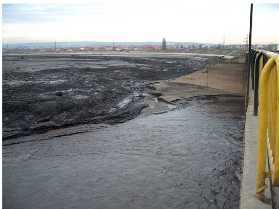
Fig.2–Zona pod și vedere dig mal stâng (cu lacul gol)
